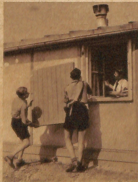
Nun noch die Holzläden eingehängt, dann ist unser Behelfsheim fertig zum Einzug
