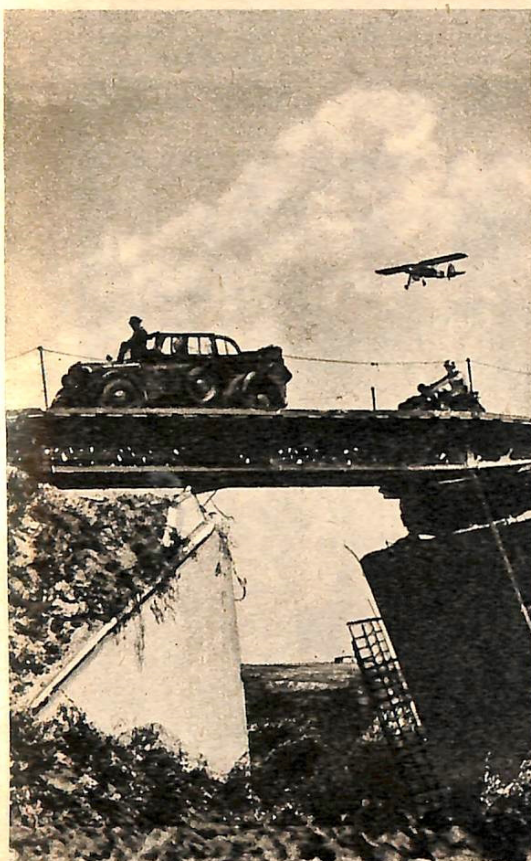
Vormarsch über die deutsche Notbrücke
